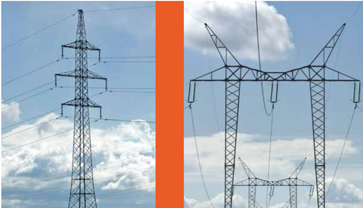
6 db fázisvezetővel és 1 db védővezetővel szerelt oszlop
